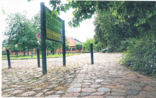
So könnte in Zukunft das Kopfsteinpflaster aussehen. Eine Probepflasterung nach Abschleifen der Steine lässt den Unterschied erkennen.
