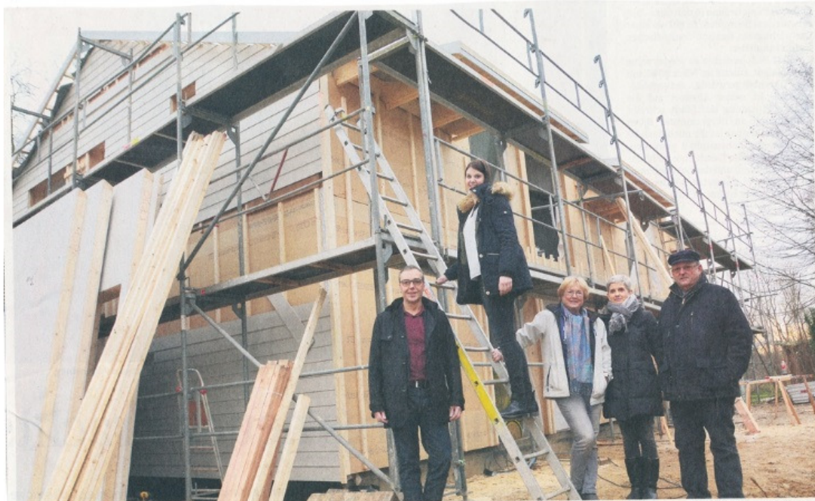
Ammersbeks Bürgermeister Horst Ansén (v.l.), Julia Albrecht, Rita Thönnies, Susann Jandt-Wahls und Jürgen Ehrig auf der Baustelle
